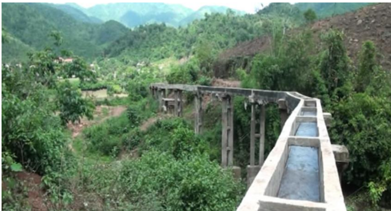
Công trình thủy lợi Huổi Pắng, ở bản Huổi Sâu, xã Pa Tần, huyện Nậm Pồ
