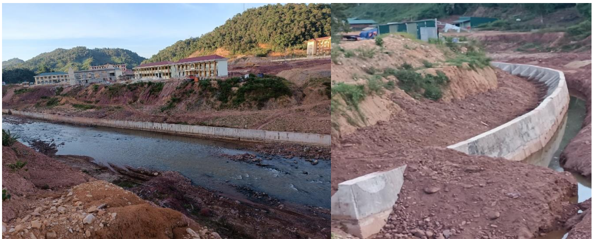
Hình 2- 6: Một đoạn kè Nậm Pồ trong thời gian xây dựng và hoàn thành
